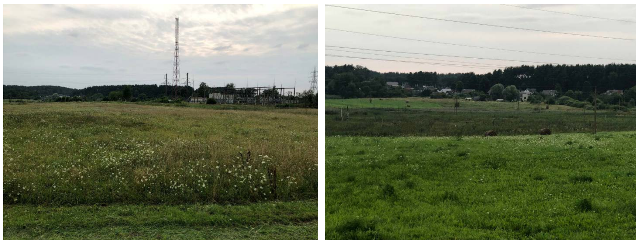
Рисунок 3.5 – Общий вид прилегающей территории к ПС «Браслав»
